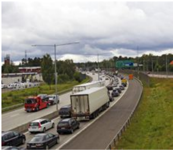
I början av september väntas arbetet med den skadade bron vara klart och köläget förbättras. Foto: MAJA NILSSON
