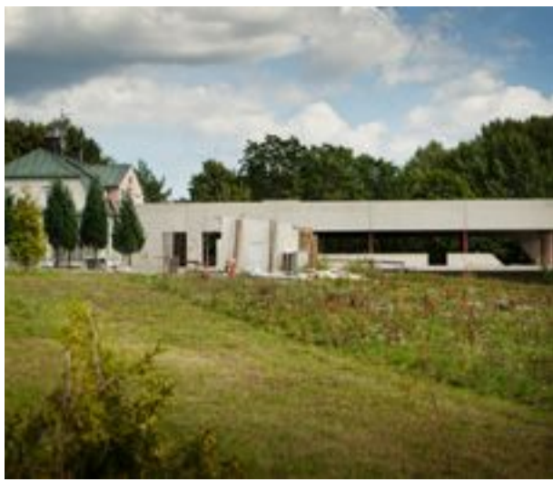
Den olovlige tillbyggnaden står fortfarande kvar.
