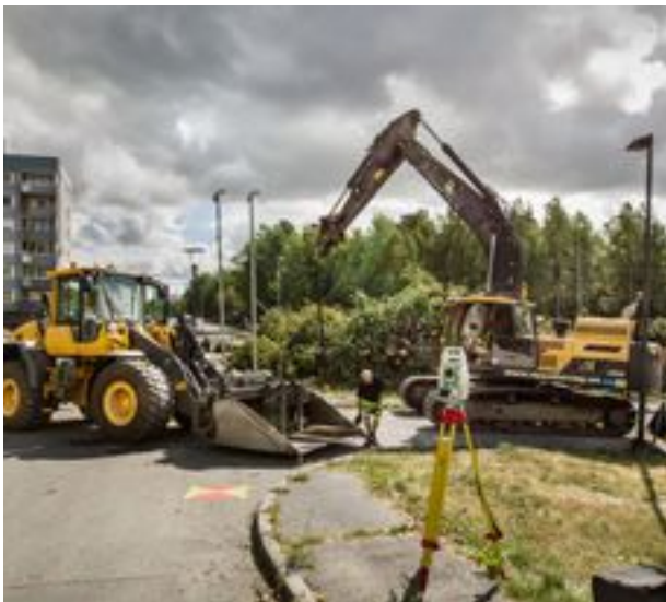
Bygget på Albyberget har börjat.
